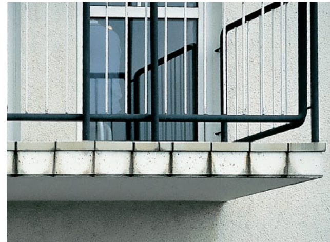
Schmutzfahnen sind unvermeidbar, wenn Oberflächenwasser unkontrolliert an der Stirnseite der Balkonkragplatte abläuft. Diese unansehnliche Aus-führung ist im Mehrgeschosswohnbereich nach DIN 1986-100 unzulässig.
