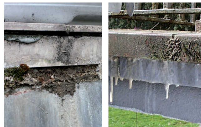
Schmutzfahnen sind unvermeidbar, wenn Oberflächenwasser unkontrolliert an der Stirnseite der Balkonkragplatte abläuft. Diese unansehnliche Aus-führung ist im Mehrgeschosswohnbereich nach DIN 1986-100 unzulässig.
